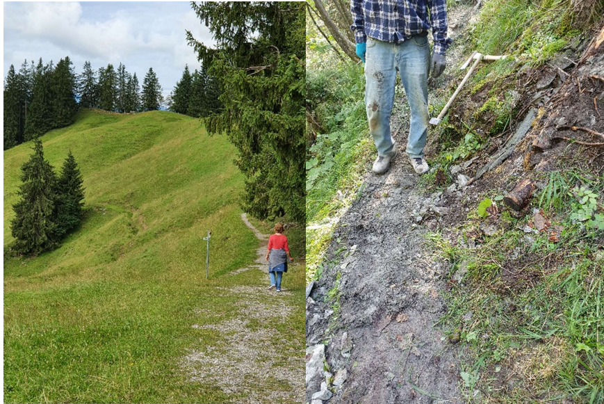
Die Wiederherstellung des Wanderweges benötigte Fachkenntnisse und Arbeitsfreude.
