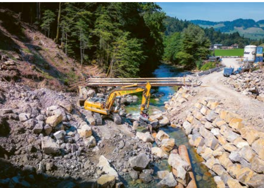
Ein Teil des Flusses musste aufgeschüttet werden, um die Zugänglichkeit der Baustelle zu gewährleisten.
