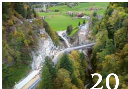
Lammschlucht Ein Grossprojekt in 3 Etappen
