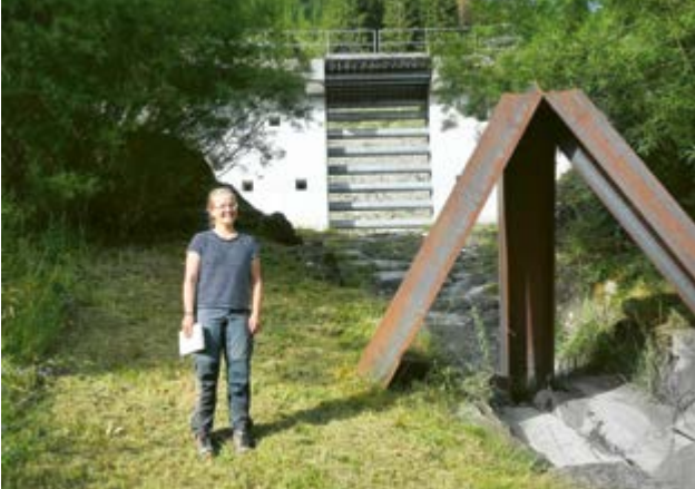
Anna Rudloff steht vor den eindrücklichen Schutzbauten in Sörenberg. Hinter ihr einer der Geschiebesammler. Rechts im Bild ein Dreibein aus Stahl, das als Bremsselement gegen Murgänge eingesetzt wird und die Fließgeschwindigkeit reduziert.
