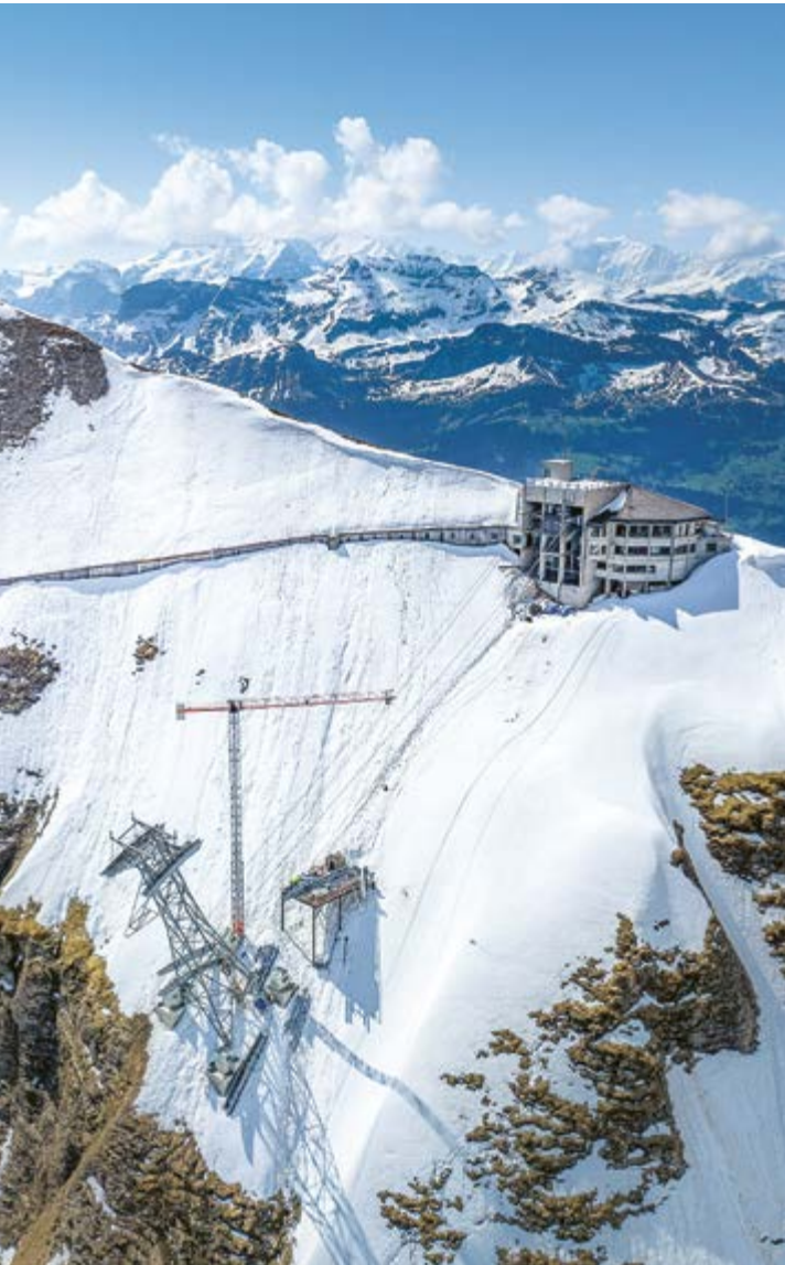
oben: Die Stütze 3 kommt 90 Meter unter der Bergstation in einem steilen Hang zu stehen. | unten: Die Talstation am Fusse des Brienzer Rothorns.
